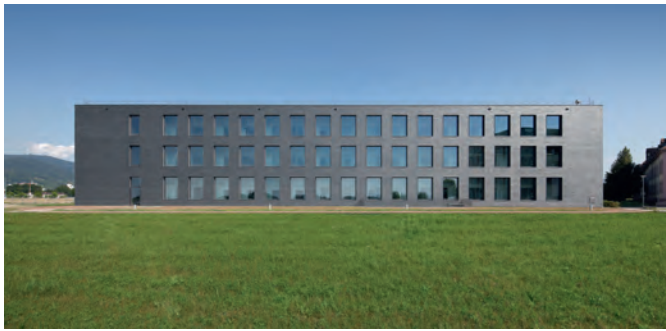
Bild 5. FIT Freiburg: Nordansicht auf den Labortrakt
