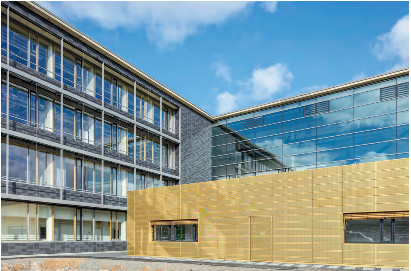
Bild 1. CAM Heidelberg: Ansicht auf TEM-Gebäude im Vordergrund und Laborbau Ost
