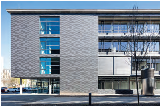
Bild 2. CAM Heidelberg: Ansicht von Westen auf Eingangshalle und Laborbau West
